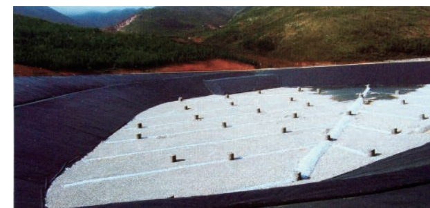
■ 无锡市锡山污水处理及再生水回用工程
