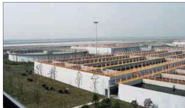
■杭州市萧山东片大型污水处理厂工程
